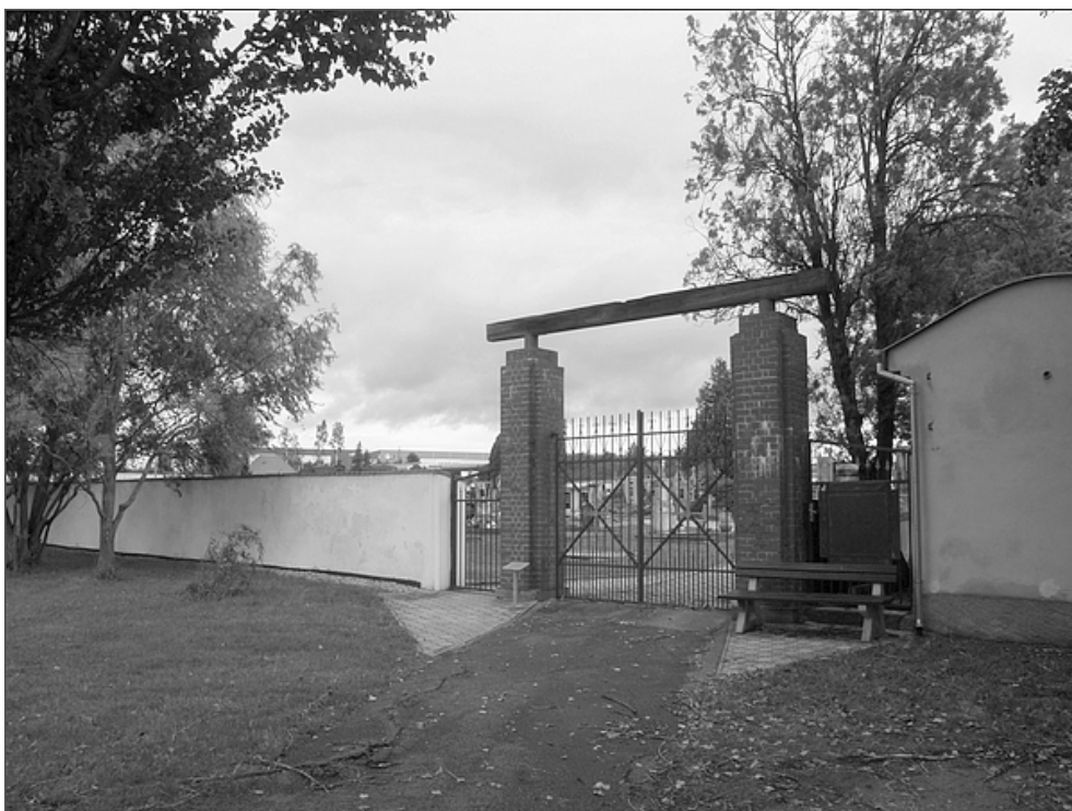
F16 – vstup na hřbitov
