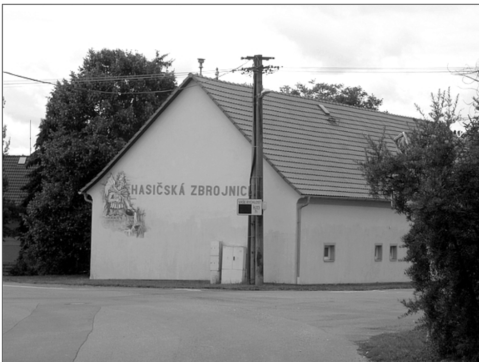
F14 – hasičská zbrojnice
